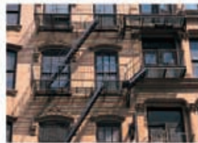
非常階段 hijō kaidan fire escape
