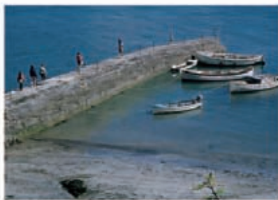
防波堤 bōhatei jetty
